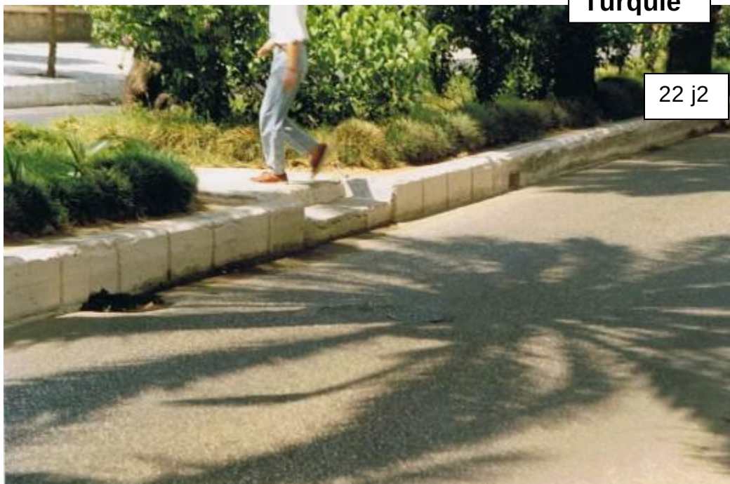
Des marches pour faciliter l'accès des piétons
