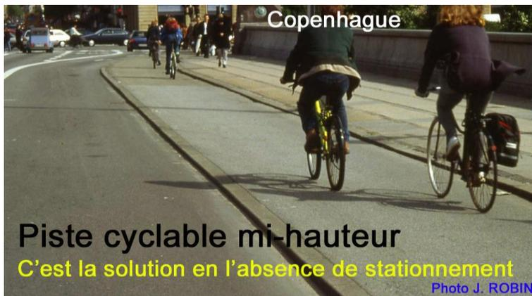
Cette piste cyclable "mi-hauteur" est très courante à Copenhague. La largeur doit être au moins 2,00 m et si possible 2,50 m afin que les cyclistes expérimentés et rapides puissent dépasser les autres et afin que les cyclistes inexpérimentés puissent circuler en s'éloignant des voitures. Le décalage en hauteur est environ 10 cm entre la chaussée et la piste et entre la piste et le trottoir.
