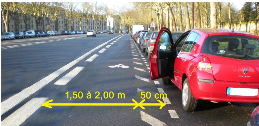
**La largeur des bandes cyclables doit être conforme au guide des aménagements cyclables et à la fiche N° 2 du CEREMA : 1,50 à 2,00 m + 0,50 m si stationnement.**
