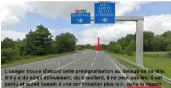
Dans les échangeurs "trompette" il y a des endroits où l'on doit choisir entre une voie à droite et une voie à gauche, or les directions ne sont données qu'en présignalisation en potence, souvent ce n'est pas lisible : brouillard, soleil, nuit. Il faudrait confirmer la signalisation en position, en nez de musoir en A, mais on ne confirme pas pour éviter les hésitations, **c'est voulu mais c'est mauvais** car cela induit des contresens.
