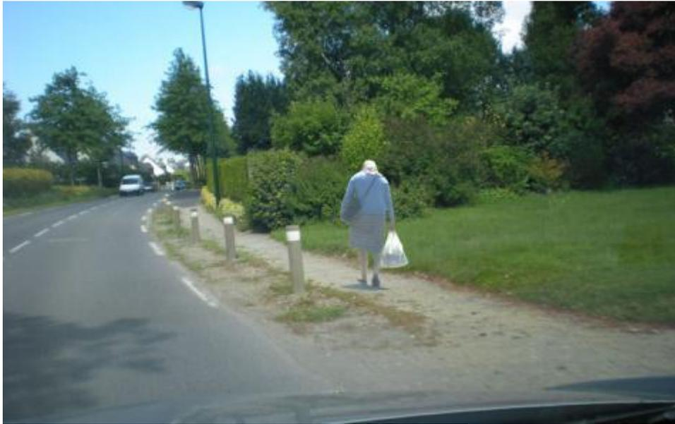
Le sentier doit être au milieu de l'accotement et être séparé de la chaussée par une largeur herbeuse (sans arbustes !)
