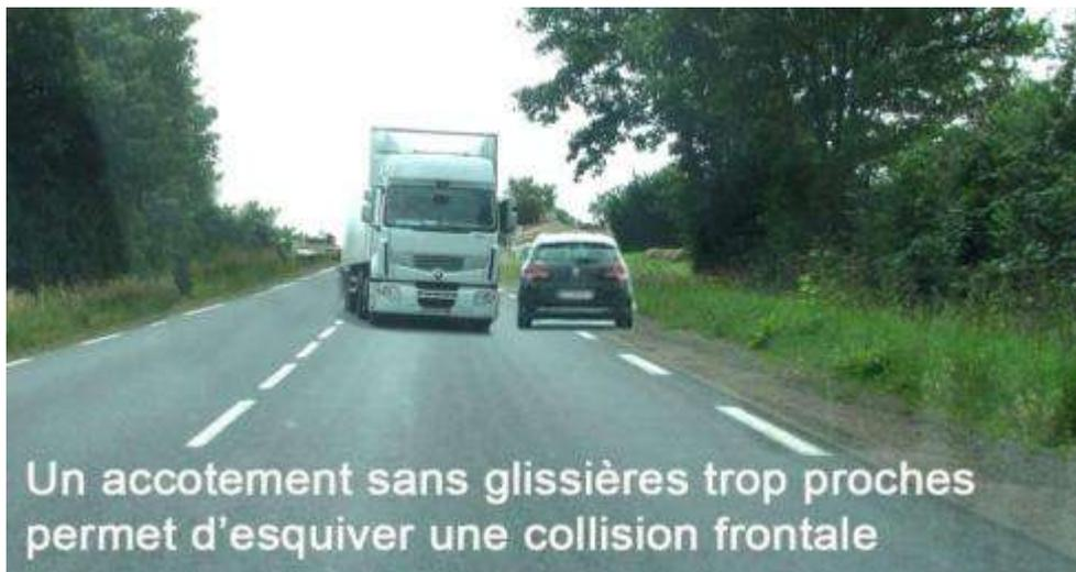
. La **"zone de récupération"** définie par le Guide des routes du CEREMA, **est faite pour** "permettre la récupération de véhicules déviant de leur trajectoire normale et l'évitement des collisions en autorisant des manœuvres d'urgence de déport latéral sur l'accotement".
