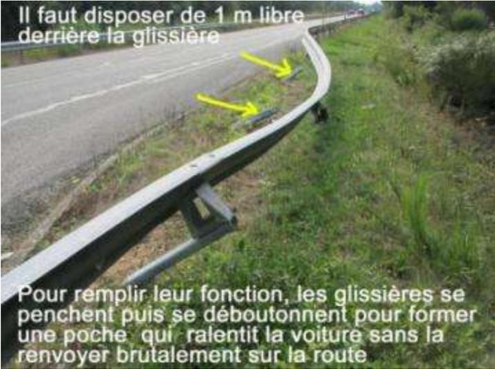
Le besoin de disposer, derrière la glissière, d'une distance  $D_m$  d'environ 1 m pour que la glissière se "déboutonne" et puisse former une poche qui ralentisse la voiture et la maintienne à droite sans la projeter à gauche.
