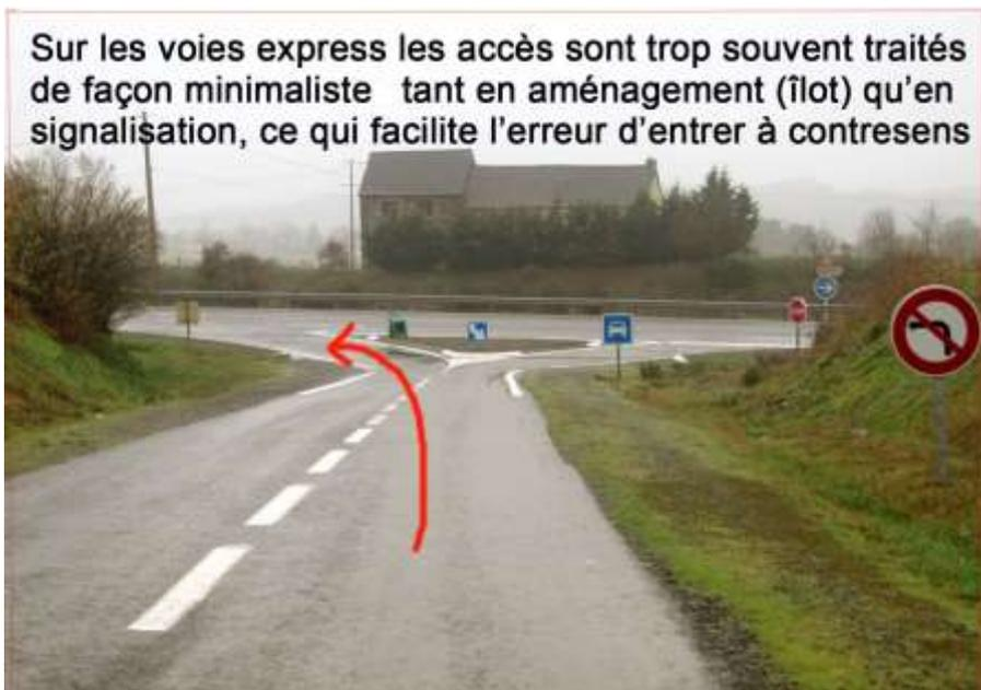
Sur les voies express, les accès sont souvent traités de façon minimaliste, depuis le "vrai échangeur" jusqu'à de simples carrefours comme la photo ci-contre où l'îlot trop petit peut provoquer des insertions à contresens et n'est pas assez long pour séparer convenablement les deux sens.
