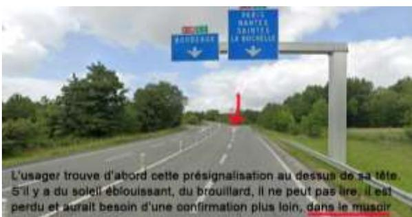
Dans les **échangeurs "trompette"** il y a des endroits où l'on doit choisir entre une voie à droite et une voie à gauche, or les directions ne sont données qu'en présignalisation en potence, **souvent ce n'est pas lisible : brouillard, soleil, nuit.** Il faudrait **confirmer la signalisation en position**, en nez de musoir, mais on ne confirme pas pour éviter les hésitations, **c'est voulu mais** cela induit des contresens beaucoup plus dangereux à 130 km/h qu'un accrochage à 60 km/h
