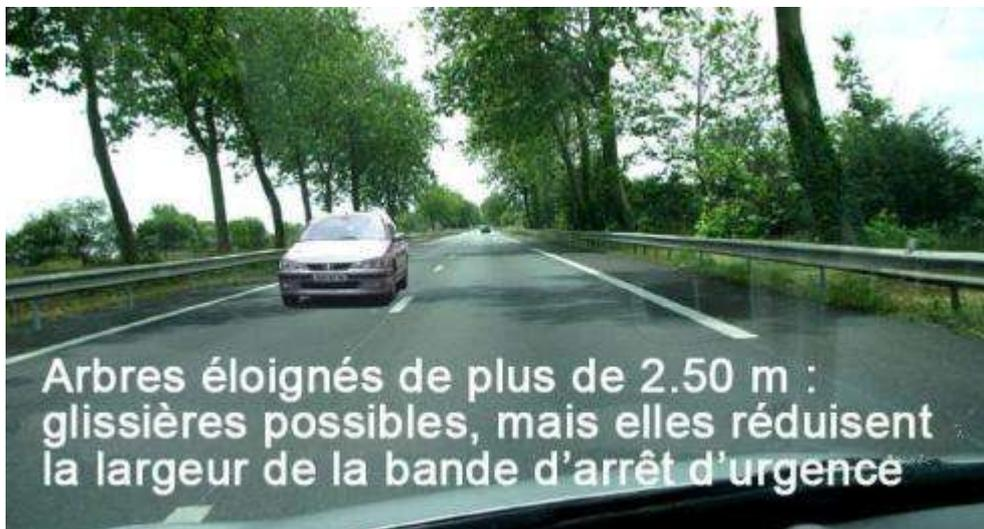
**Lorsque les arbres sont trop proches** (moins de 2,50 m), la glissière ne peut pas se déformer vers l'arrière, elle est rigide et fait ricocher la voiture vers la gauche avec risque de collision frontale. D'autre part, les glissières emprisonnent les voitures qui n'ont aucun moyen d'échapper à une collision frontale avec un véhicule en face qui ferait un écart.
