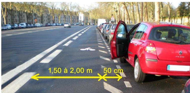
**La largeur des bandes cyclables doit être conforme aux "Recommandations pour les aménagements cyclables" de 2000 du CERTU (CEREMA actuel), reprises par la fiche N° 2 de 2015 du CEREMA : 1,50 à 2,00 m + 0,50 m si stationnement.**
