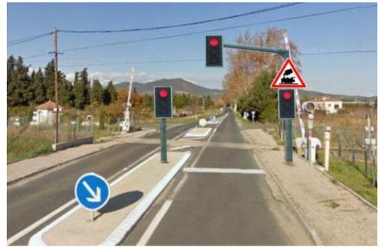
**2 → Signalisation de position** Réaliser à l'endroit du PN lui-même, une signalisation de position efficace en répétant les feux à gauche et sur portique au dessus de la chaussée et en associant un panneau A8 représentant une locomotive qui parle visuellement aux automobilistes.
