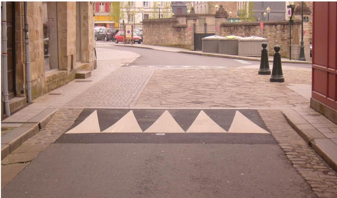
Plateau surélevé : il est recommandé de constituer les rampes ou le plateau en pavé, afin de bien le visualiser. Ne pas marquer de passage piéton sur un plateau, sauf exceptionnellement s'il se situe sur une voie très circulée.
