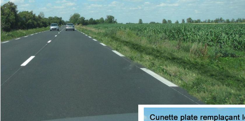
Cunette plate remplaçant le fossé et permettant ainsi de disposer d'une largeur suffisante pour réaliser une zone de récupération
