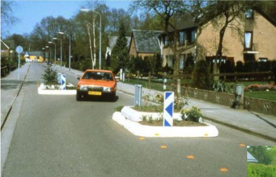
Avec by-pass cyclistes, cela permet de faire passer les cyclistes de façon sécuritaire, sans être serrés par les voitures lors du passage de la chicane
