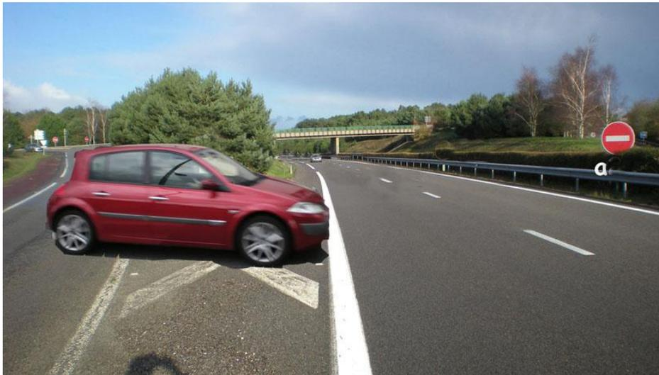
Mais le déni a ses propres limites, il peut être **contrebalancé par une prescription plus** flagrante qui consiste à placer une paire de panneaux sens interdit à 50 m en amont afin qu'il soit mieux vu. Le conducteur les verra bien en face **lorsqu'il s'apprêtera à amorcer** sa mauvaise manœuvre et ces deux panneaux **ne permettront plus ni le déni**, ni la distraction, le conducteur **sait qu'il ne pourra plus prétendre ne pas avoir vu**.
