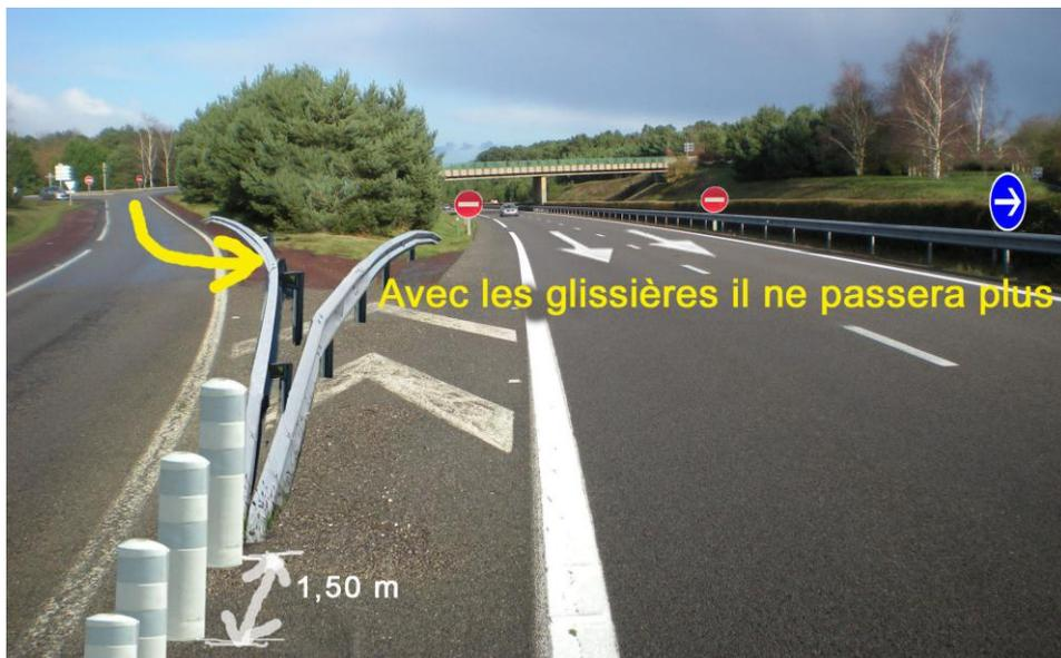
Une disposition supplémentaire, qui figure sur les photomontages ci-contre consisterait à empêcher matériellement la manœuvre de contresens, soit en implantant une barrière de sécurité avant les balisettes.
