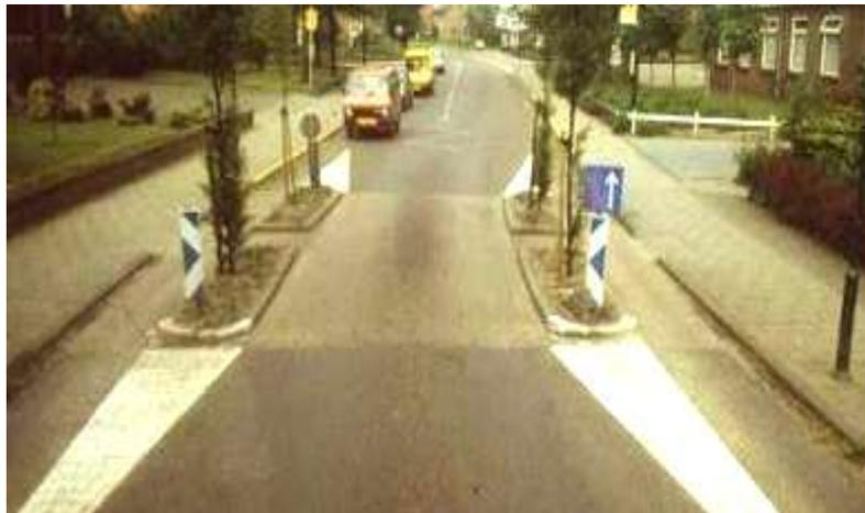
**l'écluse LATÉRALE simple** est réalisable même dans le cas d'une chaussée étroite et que l'on ne dispose pas de beaucoup de largeur : c'est en fait une avancée de trottoir d'un côté. Le ralentissement est plus fort dans le sens qui circule sur le côté de l'avancée de trottoir et peu important dans l'autre sens du fait qu'il ne subit pas de déflexion de trajectoire.
