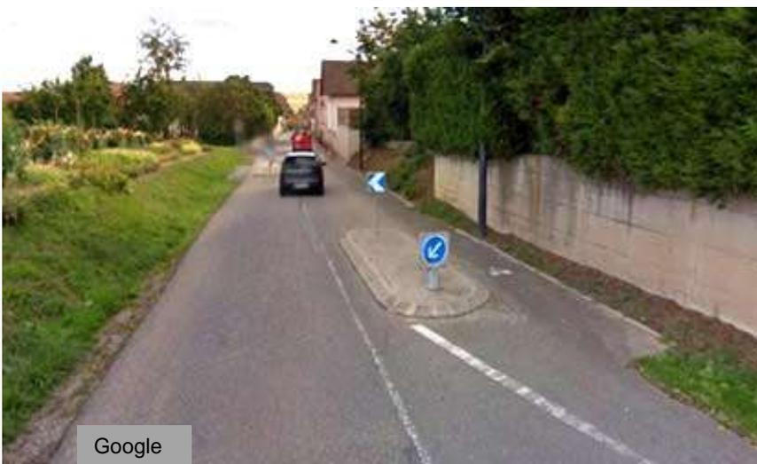
**Quelques autres exemples d'écluses doubles sur des voies à forte vitesse, par exemple en entrée d'agglomération.
