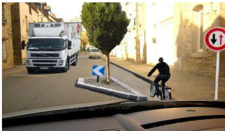
**L'écluse DOUBLE** est formée de deux avancées de trottoir successives : la première à droite, suivie de l'autre à gauche. L'écluse est donc constituée de l'espace situé entre ces deux avancées : lorsqu'un véhicule d'un sens est dans l'écluse, l'autre sens doit attendre. Son emploi est possible jusqu'à un trafic de 700 véhicules/heure (7000 v/j). **L'écluse double fait bien ralentir, dans tous les cas, même aux heures où il y a peu de trafic.**
