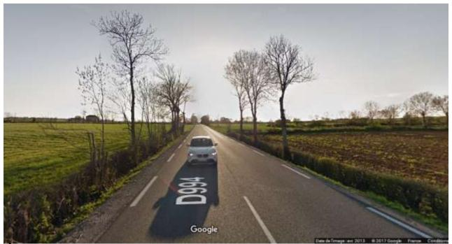
Élargissement exagéré de la chaussée au détriment de la largeur laissée à l'accotement. Conséquences : arbres très proches et absence d'accotement et de zone de récupération dérasée.
