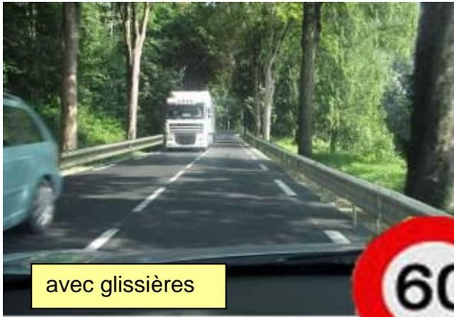
Les arbres trop proches sont dangereux, les glissières trop proches sont dangereuses car elles font rebondir sans amortir. Les deux cas nécessitent une limitation de vitesse sur la courte section de l'alignement d'arbres.
