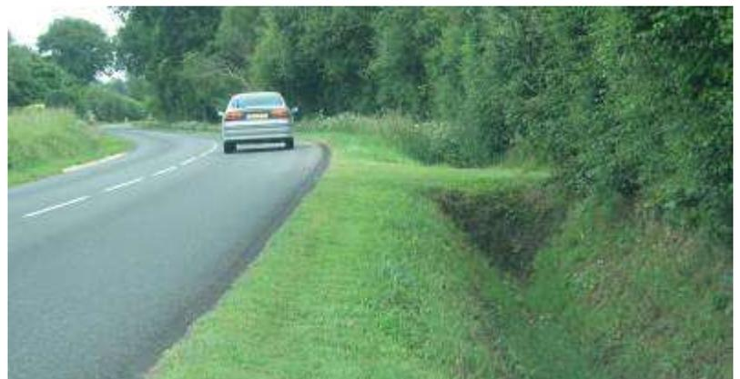
**C -- Les routes intermédiaires** de 6 mètres environ, comportant un accotement de largeur confortable (1,50 m à 2 m), mi herbeux mi pierreux, pas vraiment roulant mais on peut s'y échapper sans trouver d'obstacles latéraux trop proches. Ces routes sont marquées en axe et parfois en rives. Elles constituent une catégorie intermédiaire entre les routes secondaires classiques et les routes principales.
