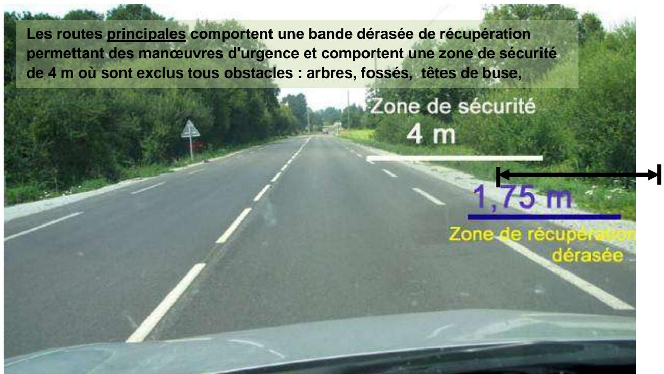
2<sup>ème</sup> différence : la largeur de chaussée. En ce qui concerne la largeur, sans que ce soit expressément défini, le guide d'aménagement des routes principales (ARP) se réfère (en 2.3) à une largeur **minimale de chaussée de 6 m pour les routes principales.** De même le document "Sécurité des routes et des rues" (en 5.1 et 6.1), sans non plus en faire une règle totalement rigide, se réfère à la largeur de 6 m pour différencier les routes principales des routes secondaires.
