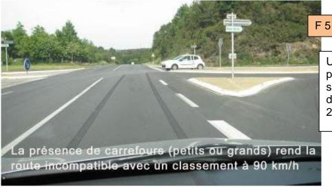
Un tel carrefour peuvent être acceptés s'il n'y en a qu'un ou deux sur la section de 20 km Il faut transformer en giratoire tous les carrefours avec voie de tourne à gauche centrale (photo F1 ci-dessus)
